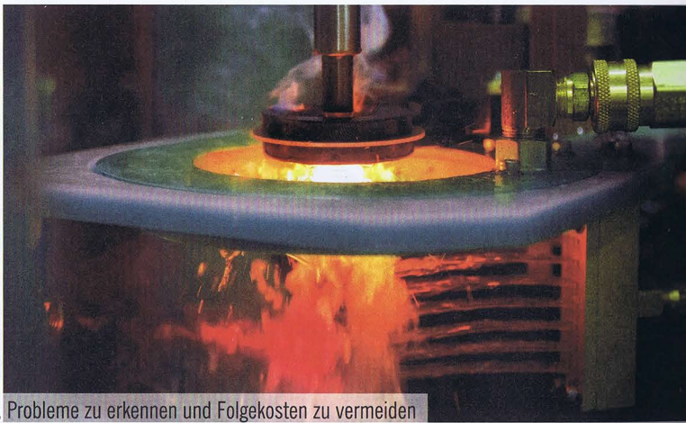
Bild 1. Bei Inductoheat vernetzt das softwarebasierte System „Emsyst 4.0“ erstmals nicht ein Gebäude, sondern eine Härtereianlage.
